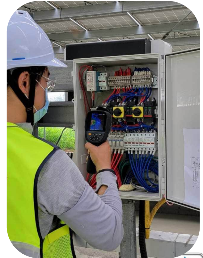
箱體紅外線 非破壞性檢測
