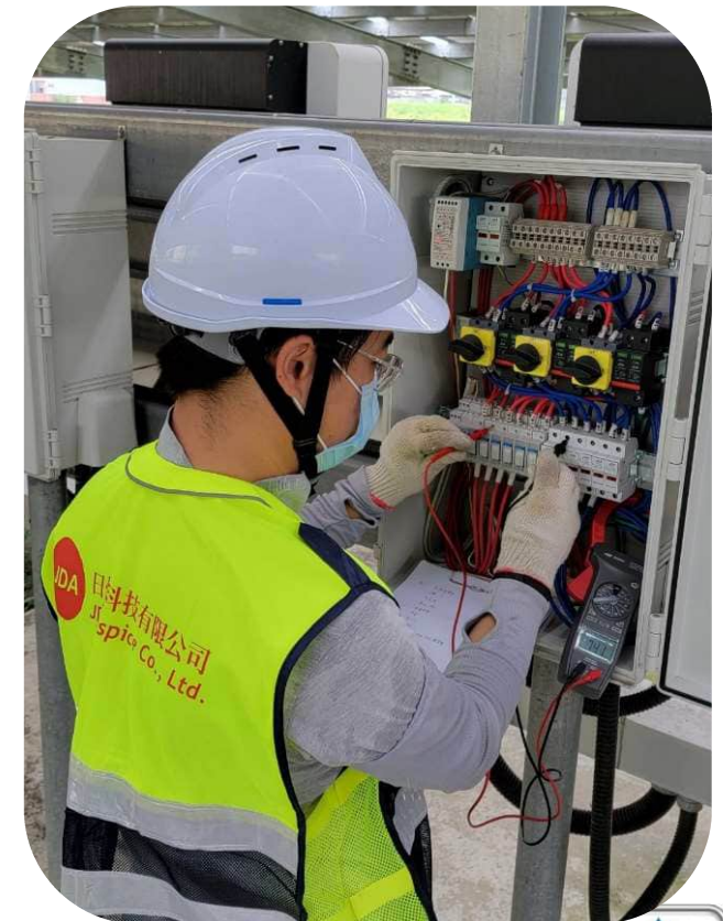
工作電壓量測
